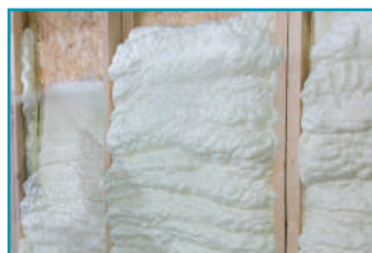
SELLADO DE PANELES DE AISLAMIENTO TÉRMICO Y ACÚSTICO
