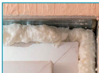
AISLAMIENTO DE PENETRACIONES
